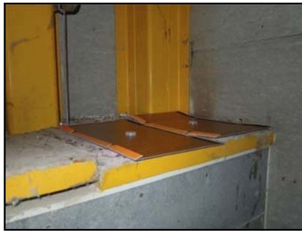
図-7 ネズミ用粘着シートの設置
