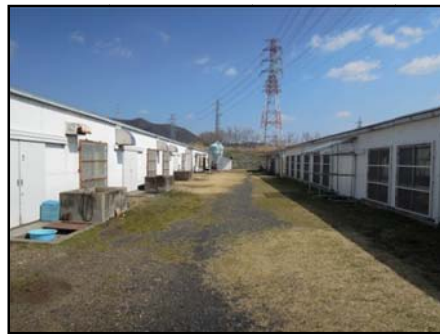
図-10 場内の清掃風景
