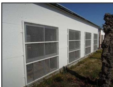
図-5 窓への金網の設置
